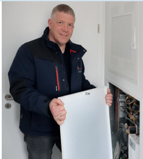
Das Herzstück der Heizung und Warmwasserverteilung: Die Clage-Übergabestation mit Plattenwärmetauscher, Durchlauferhitzer und Heizkreisanbindung für die Fußbodenheizung.
